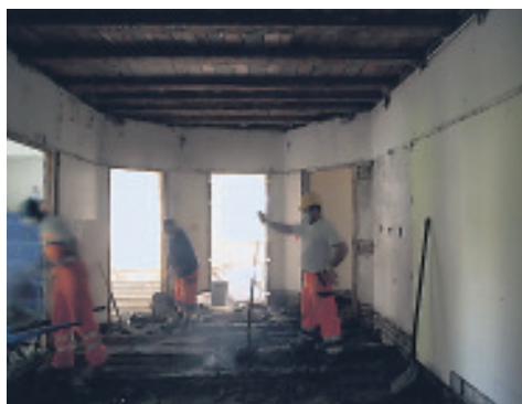
Aufwändig: Bauarbeiter spitzen die alten Böden im Foyer heraus.
