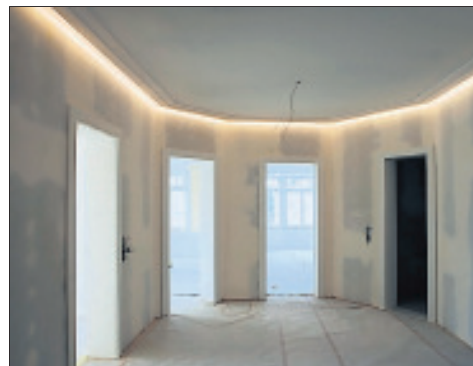
Freundlicher: Wenige Wochen später präsentiert sich das Foyer im Rohbau.
