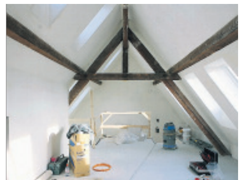
Holzbalken verstärkt: Blick in den neu ausgebauten Dachstock.
