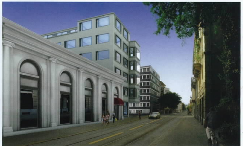
Aus Alt mach Neu: Das Kino Razzia wird um ein Wohn- und Geschäftshaus erweitert.
