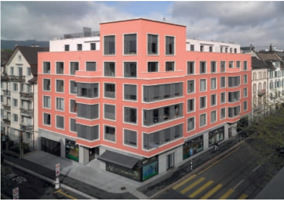
Das Münchhaldeneck nach der Fertigstellung 2011. (Thomas Alder)
