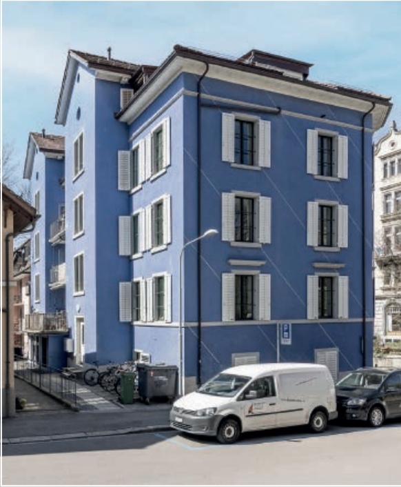
2025 Dolderstrasse 26 und 28, Zürich
