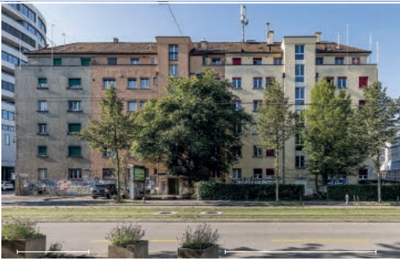
2012 Badenerstrasse 429 und 431 (r.), Zürich
