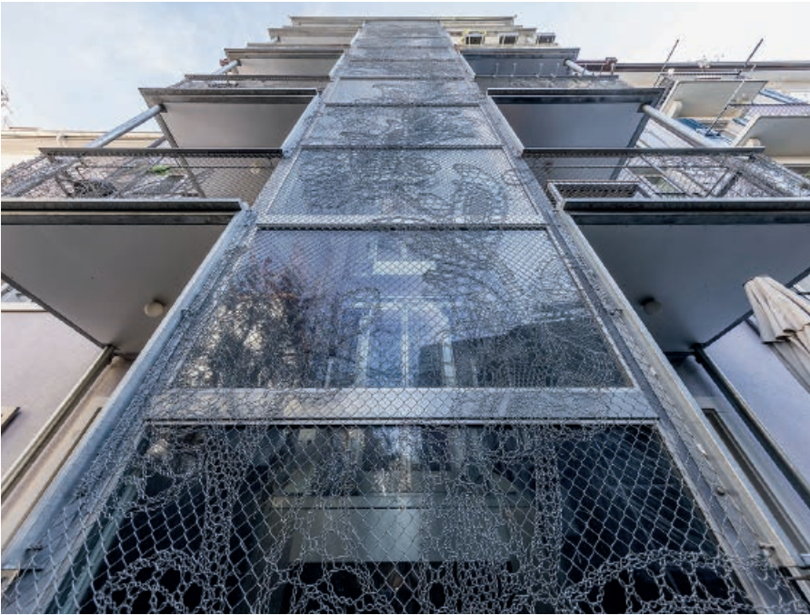
Verkleidung des Liftturms an der Seefeldstrasse 204 mit an Stickerei erinnerndem Maschendraht. (Peter Knup)
