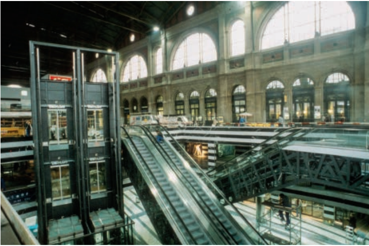
Halle des Hauptbahnhofs Zürich von Trix und Robert Haussmann, 1987–1991. (BAZ)
