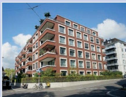
2005 Wildbachstrasse 55, 57 und 59, Zürich
