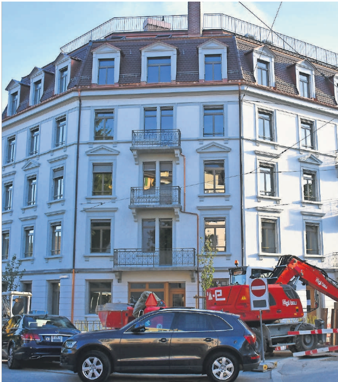
Die Fassade des Hauses an der Hammerstrasse 44 wurde ebenfalls erneuert. Die Baumaschinen täuschen: Sie gehören zum Strassenbauprojekt der Stadt Zürich.
