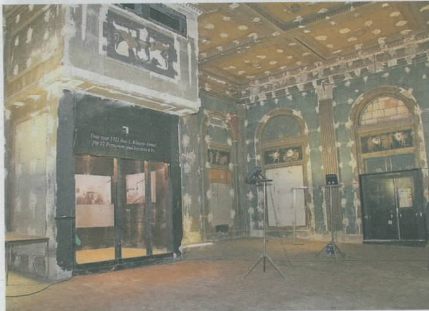
Das ehemalige Kino Razzia im Seefeld wird renoviert. SOM
