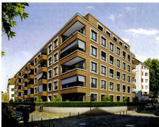
In der Wohnüberbauung Wildbachgut im Zürcher Seefeld entstehen Ende des Jahres 64 Wohnunikate.
