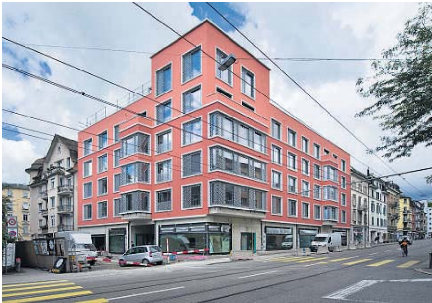
Neues markantes Gebäude am «Münchhaldeneck»: Besonders auffallend sind die speziellen Fenstergitter.
